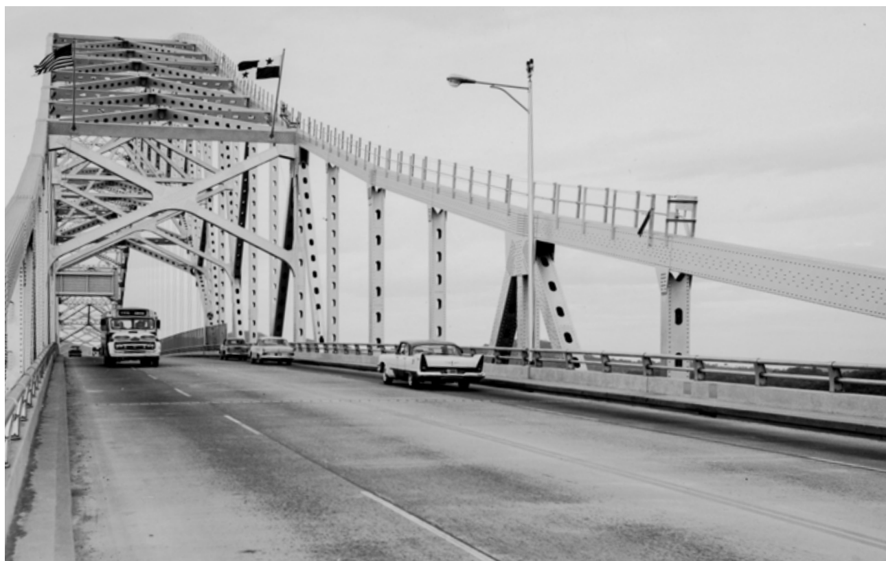
Las banderas de Estados Unidos y Panamá ondeando juntas en el puente de las Américas.
