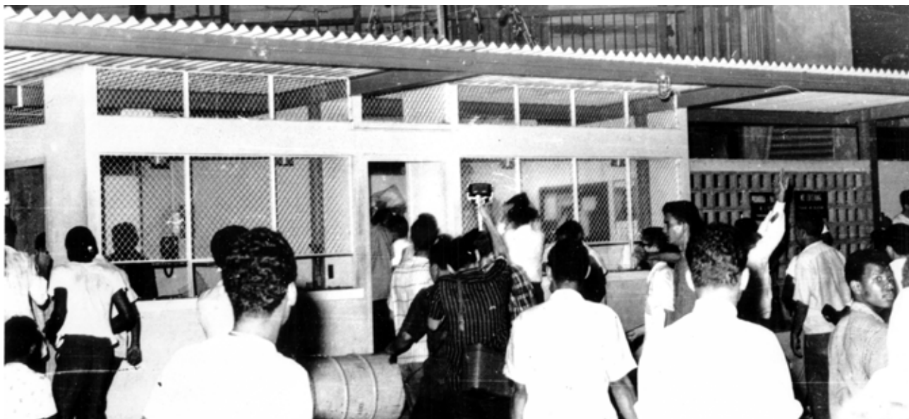
Ataque a la terminal de buses de la Zona del Canal en la plaza Shaler.
